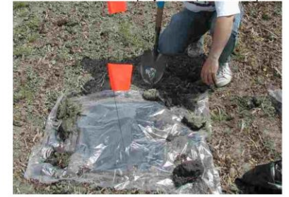
D. Installation du polythène (si besoin, pour réchauffer le sol).
