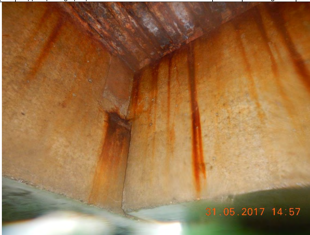
Face latérale nord de la poutre P-1 no. 1 côté ouest de la cale de halage – condition type au droit de l'appui est
