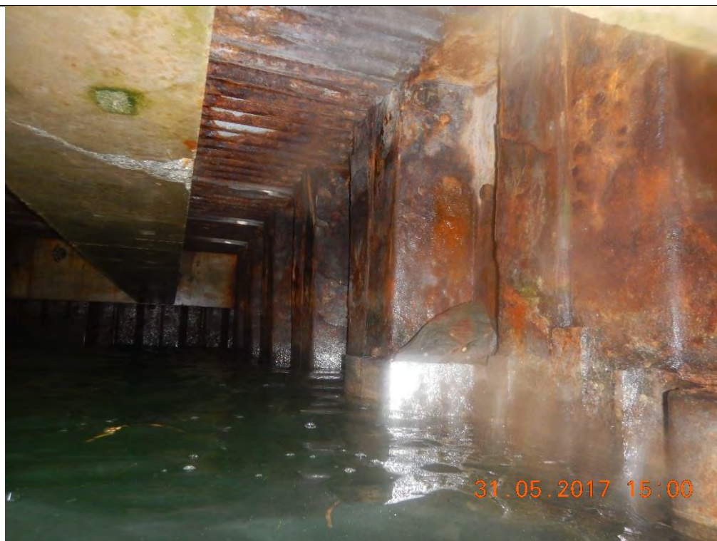
Mur de palplanches nord en-dessous du tablier côté ouest de la cale de halage
