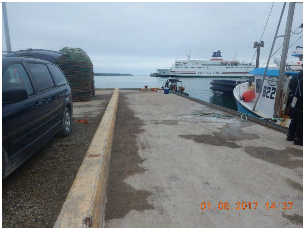
Vue générale du tablier côté est de la cale de halage – vue vers le sud
