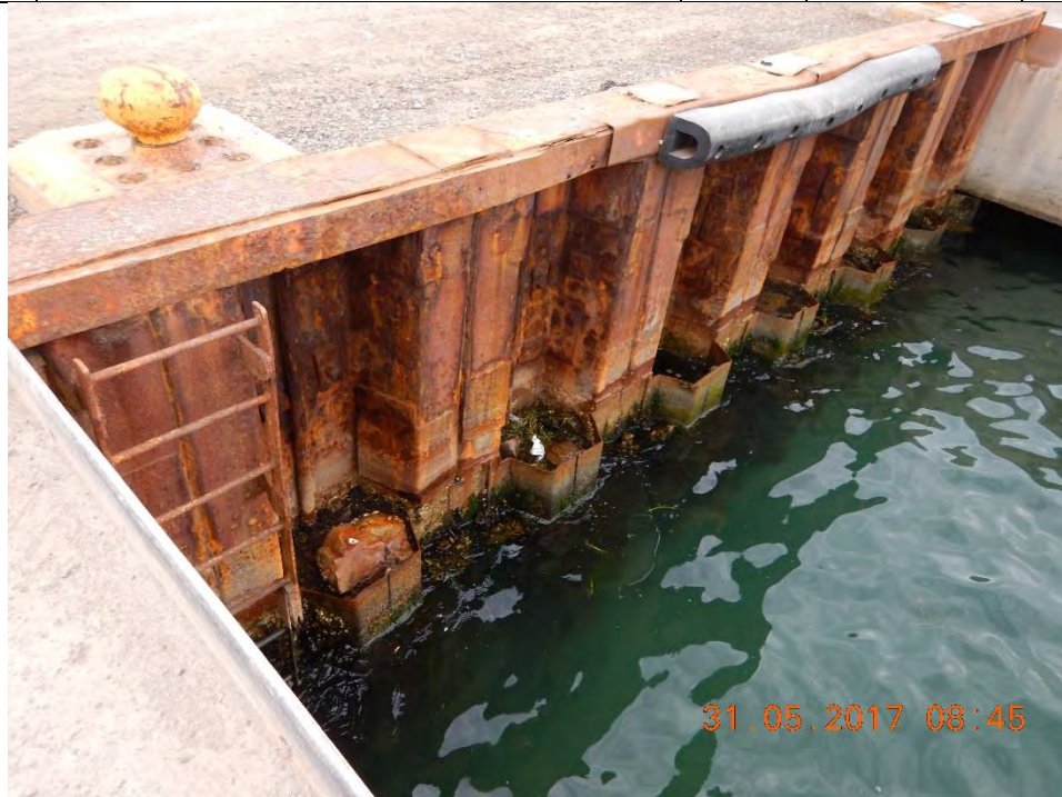
Mur de palplanches nord entre les poutres P-5
