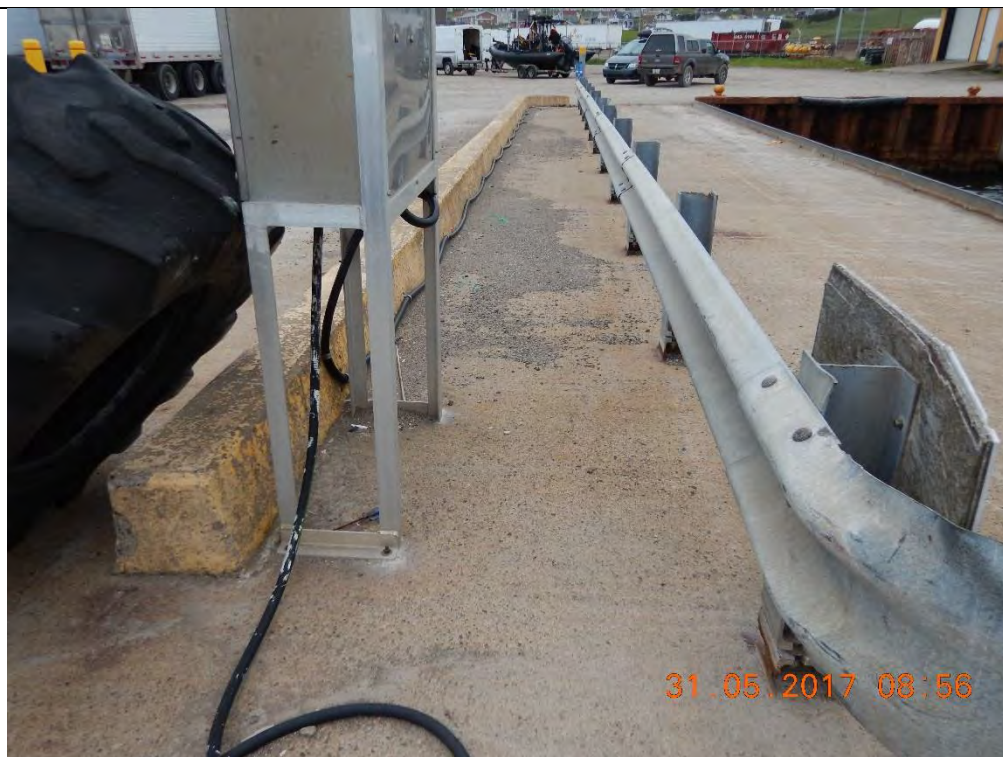
Dalle du tablier côté ouest de la cale de halage – glissière et chasse-roues en béton
