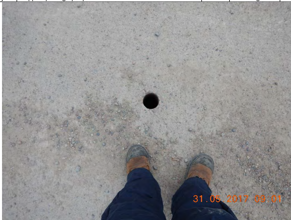
Trous de 75 mm de diamètre dans la dalle du tablier
