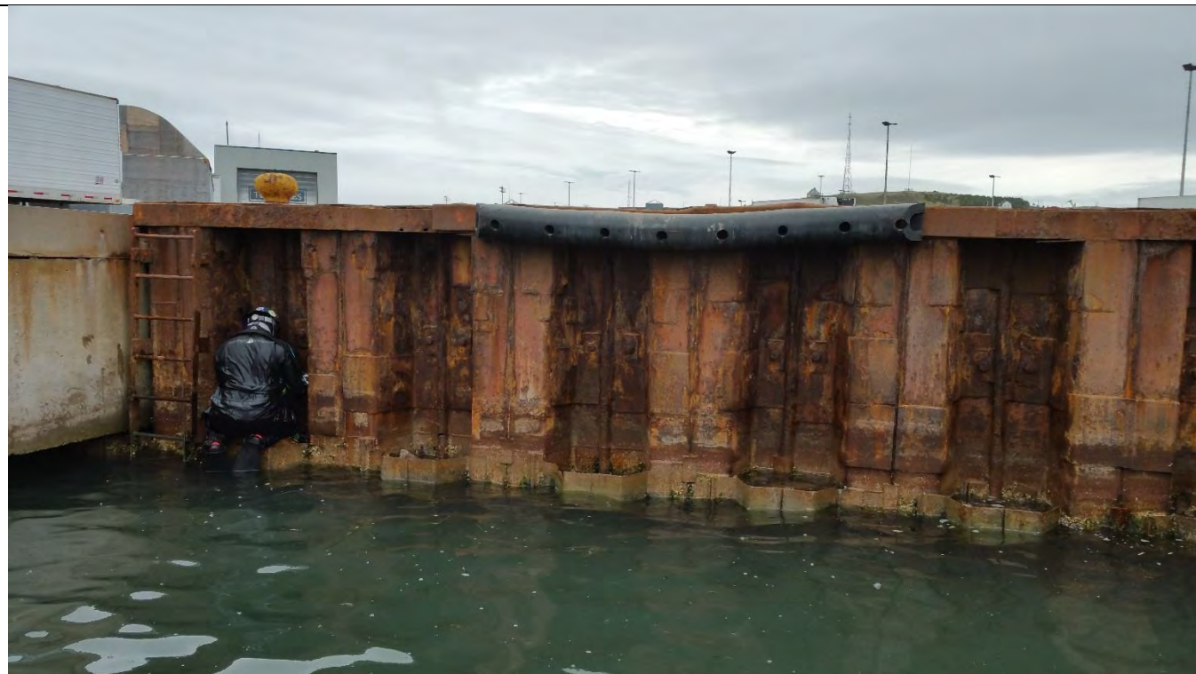
Mur de palplanches nord entre les poutres P-5
