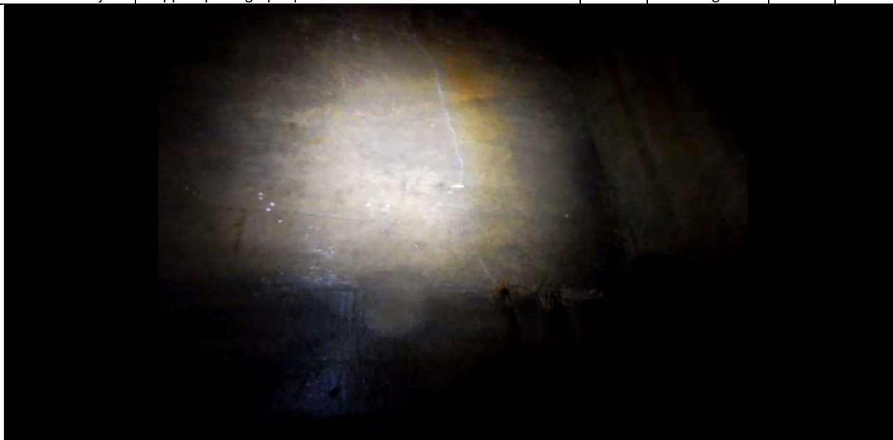
Face latérale nord de la poutre C-2 côté ouest de la cale de halage – fissure 45° près de l'appui ouest
