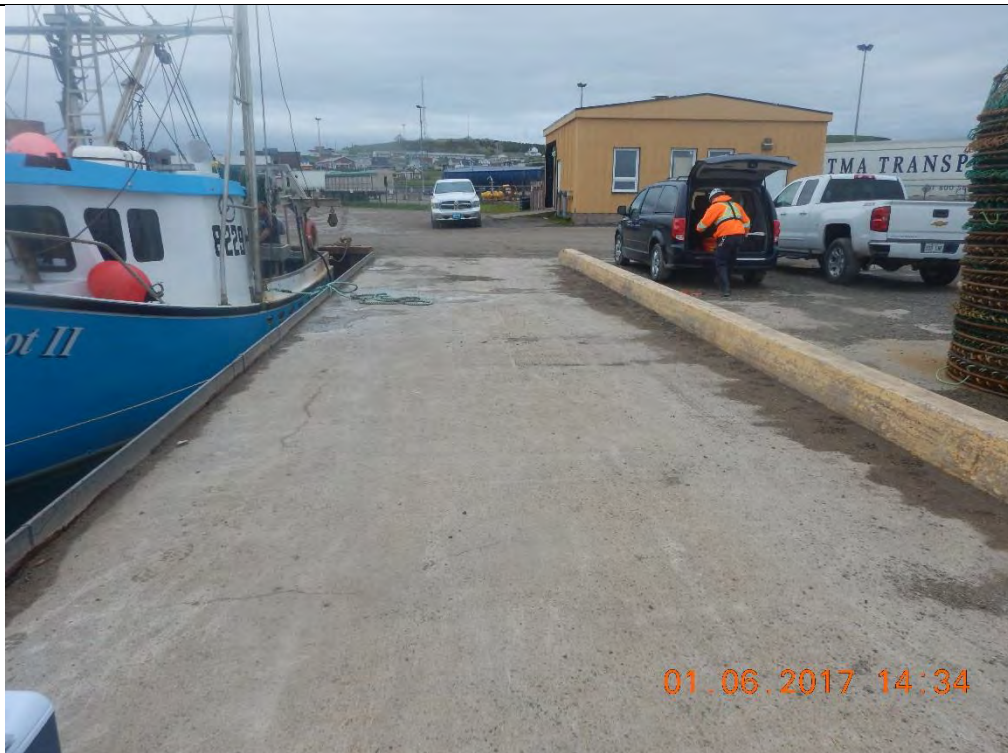
Vue générale du tablier côté est de la cale de halage – vue vers le nord
