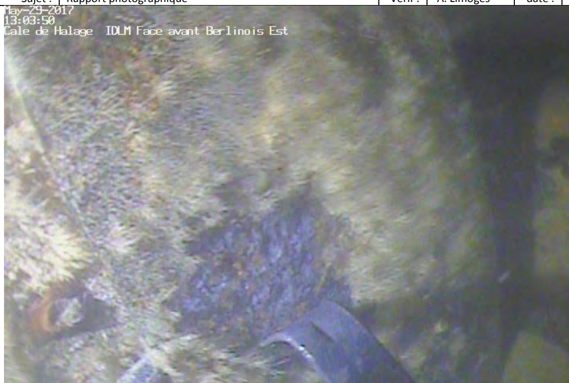
Pieux du mur berlinois latéral est situé entre la colonne B4 et C4 – condition de la surface de l'acier
