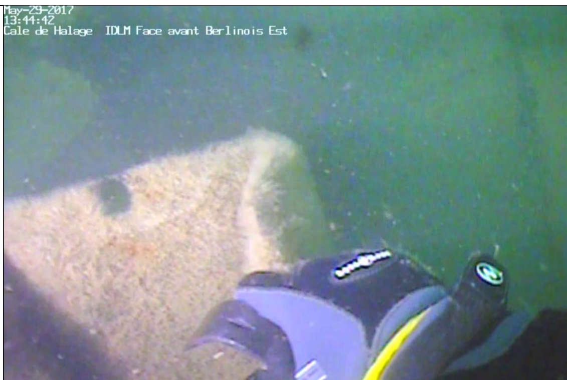
Pieux de l'ancienne structure du quai, coupé sous le niveau de l'eau – près de la colonne A3.6
