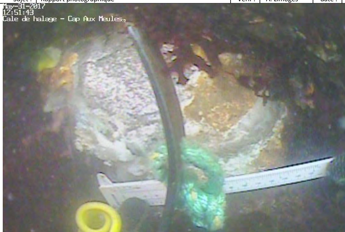
Anode sacrificielle – Pieu de la colonne D3
