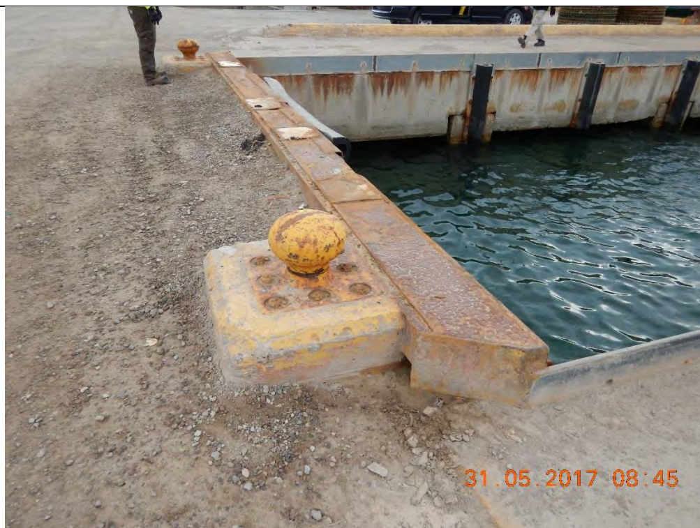
Vue générale du dessus du mur de palplanches nord
