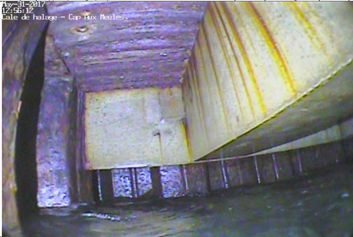
Mur de palplanches nord en-dessous du tablier côté est de la cale de halage
