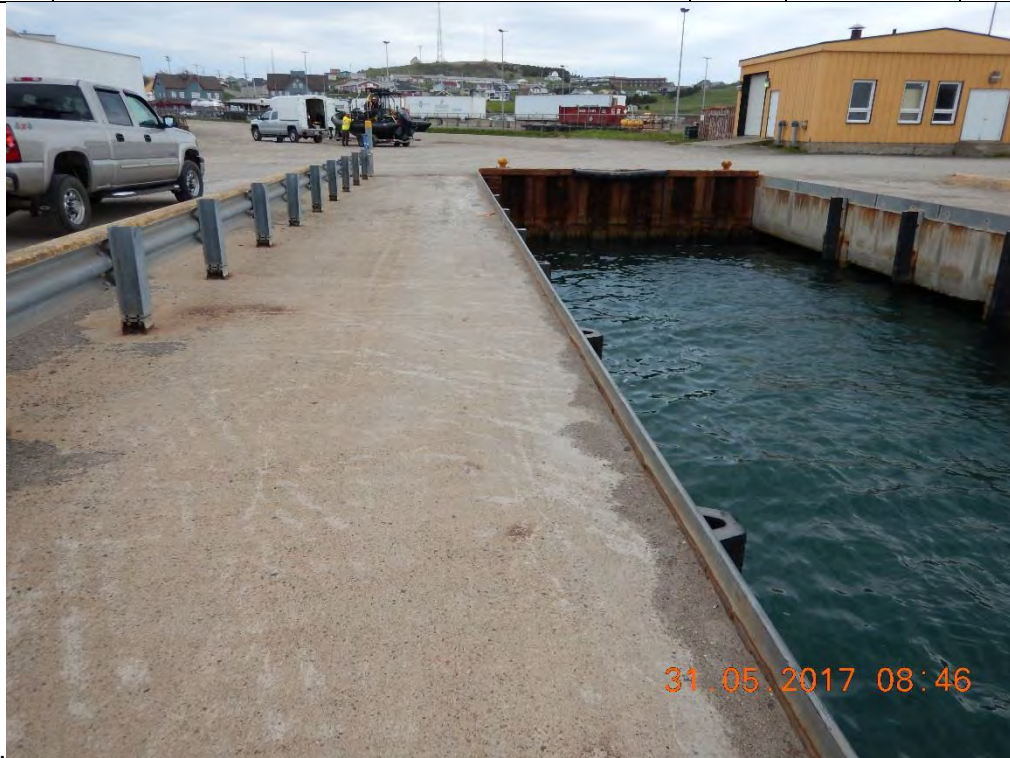
Vue générale du tablier côté ouest de la cale de halage – vue vers le nord
