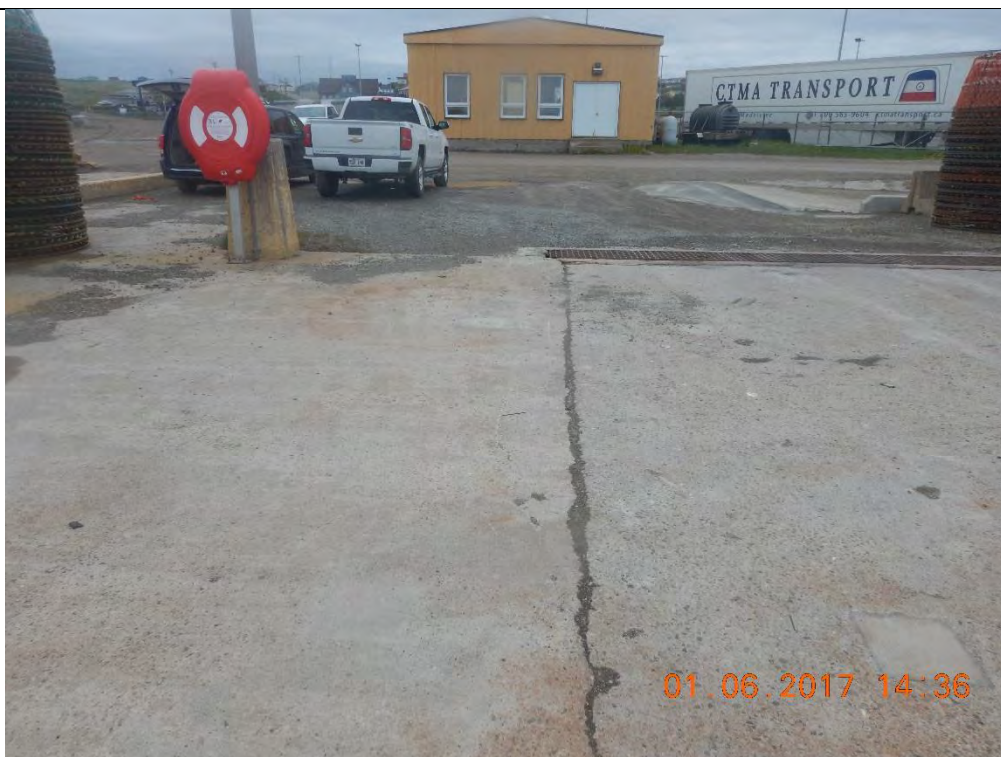
Limite ouest entre la dalle du tablier de la cale de halage et la dalle du tablier de l'ancien quai
