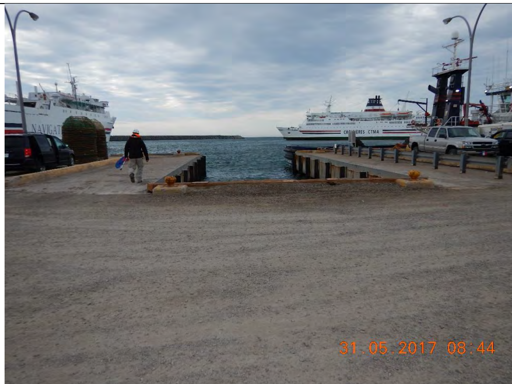
Vue générale de la cale de halage – au centre
