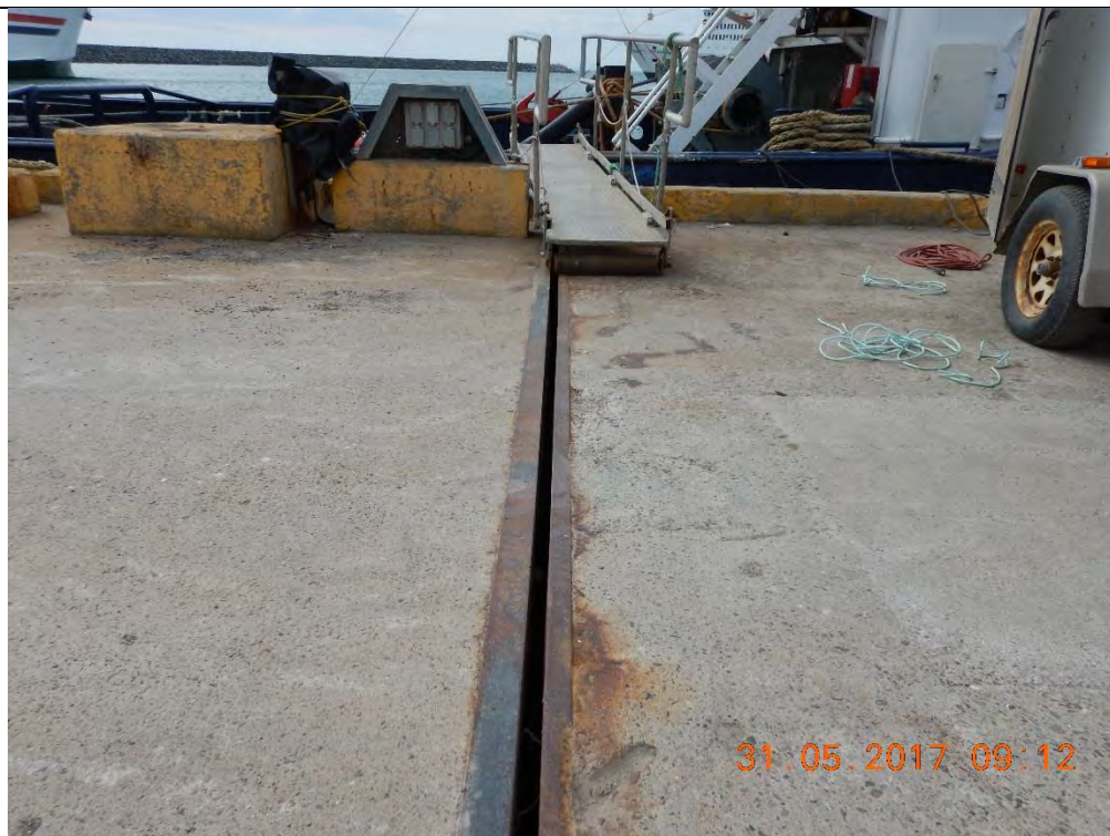
Limite est entre la dalle du tablier de la cale de halage et la dalle du tablier de l'ancien quai – Joint d'expansion
