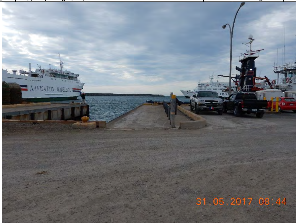
Vue générale de la cale de halage – vers le sud
