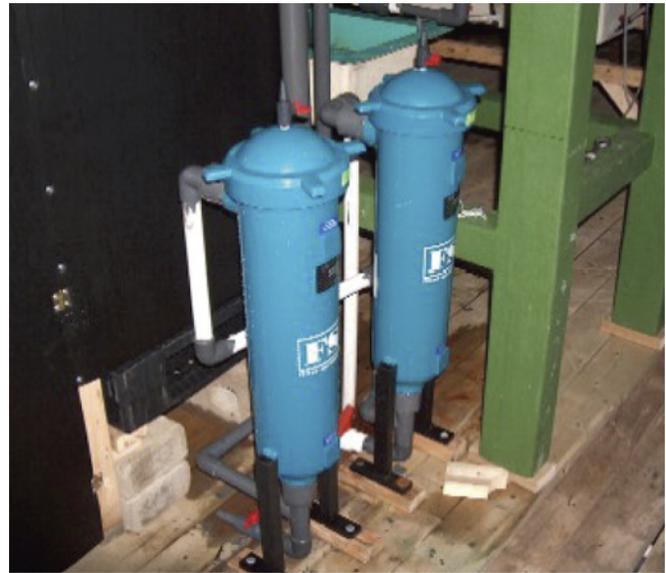
18. La filtration de l'eau d'incubation est réalisée à 25 et à 10  $\mu\text{m}$  au CAMGR; elle est couplée à une stérilisation U.V. de 240  $\mu\text{Ws}/\text{cm}^2$ .
