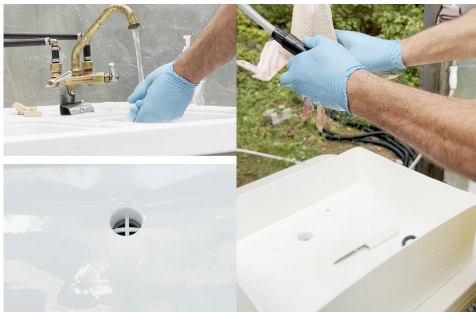
Photo 1.6 Lavabo avec de l'eau courante potable, facilement lavable et muni d'un drain d'égouttement sécurisé
