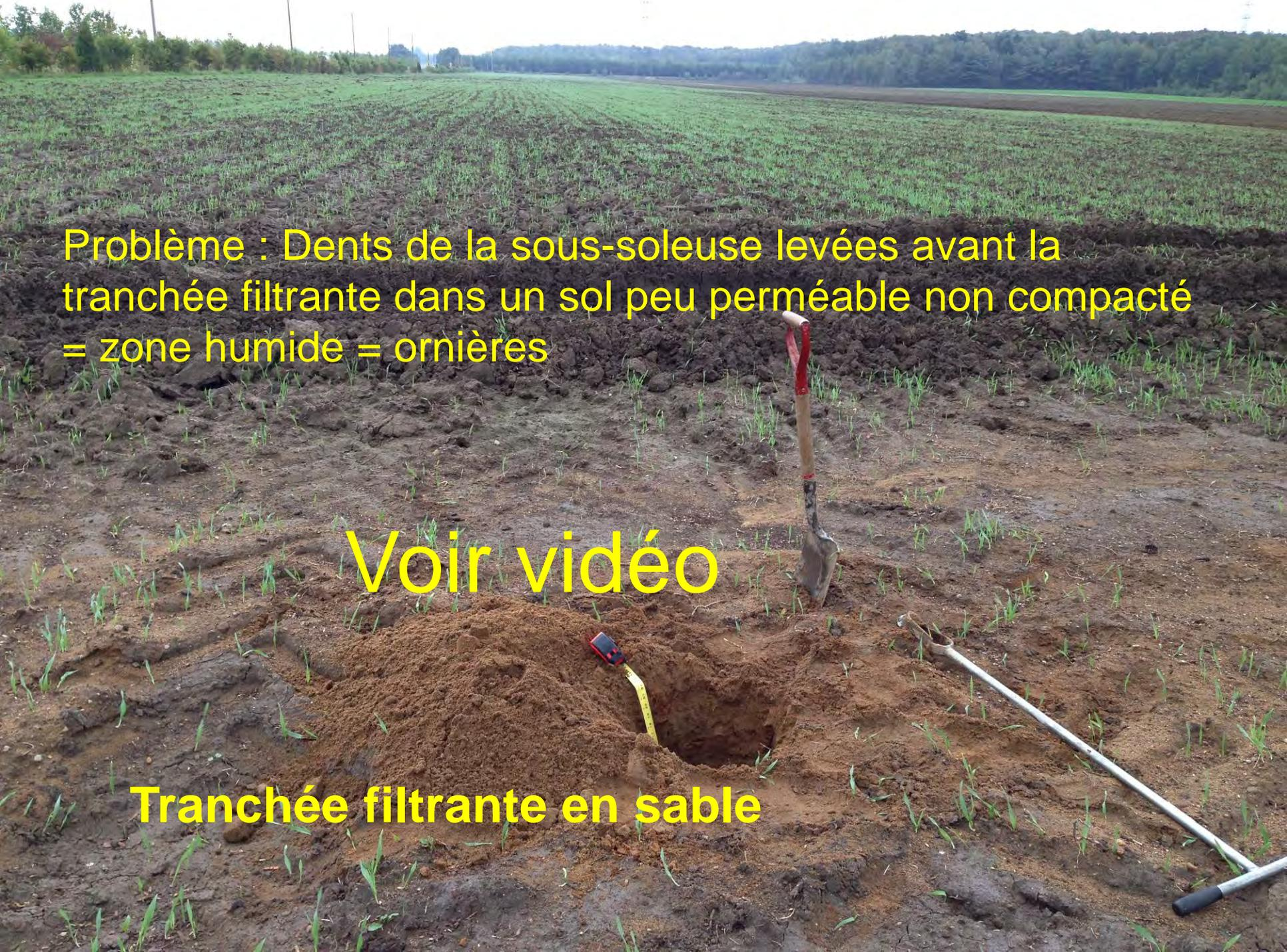
**Problème : Dents de la sous-soleuse levées avant la tranchée filtrante dans un sol peu perméable non compacté = zone humide = ornières**
