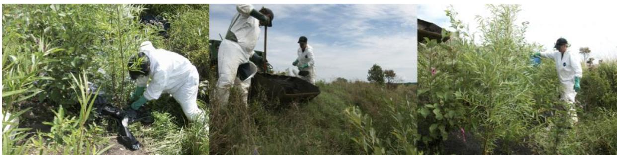
**Figure 9 : retrait des paillis de plastique et préparation du lit de germination pour l'ensemencement d'un mélange ombrophile le 3 septembre 2014 (photographies : P. Boivin).**
